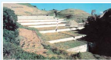
排土工完了（昭和58年）排土量27万㎡
