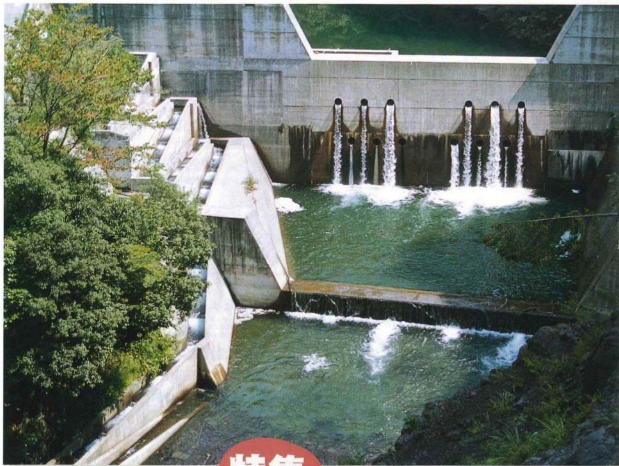
2級河川太田川・魚道付砂防ダム (森町亀久保地先) H=13.0m、L=62m 施工年度 S59～63
