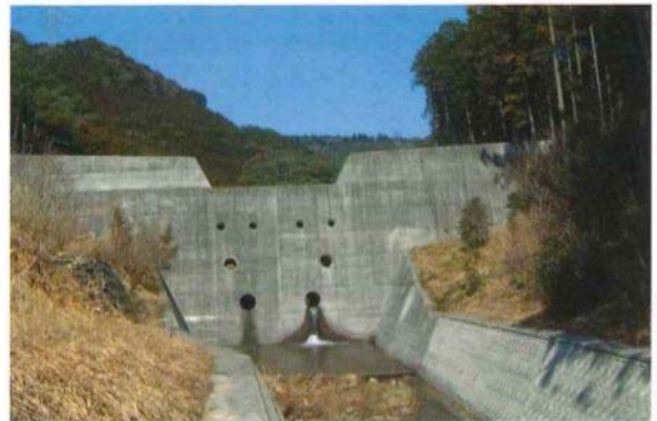
本坂北川砂防堰堤
