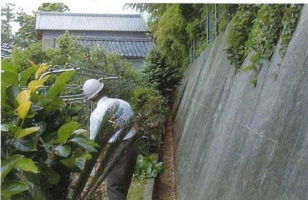
山宮神地区急傾斜地崩壊防止施設
