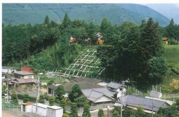
田森地区急傾斜地崩壊防止施設
