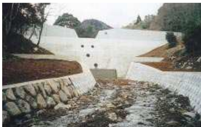
熊明ノ沢砂防堰堤
