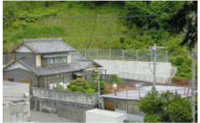
西之谷急傾斜地崩壊危険区域
