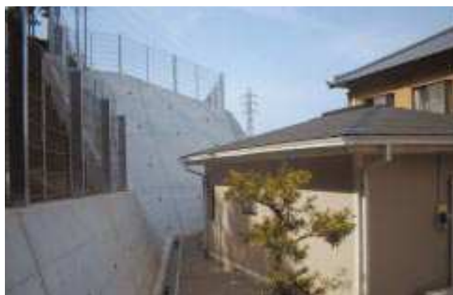
皆沢急傾斜地崩壊危険区域
