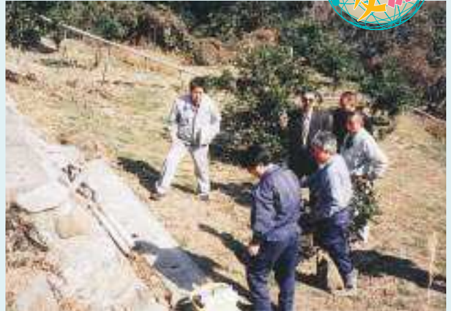
西倉沢地すべり対策工(横ボーリング工)の視察
