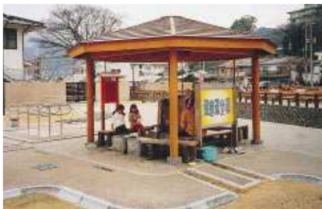
湯らっくす公園の足場
