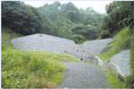
やなぎさわ 柳沢砂防えん堤 (志太郡岡部町内谷地先)
