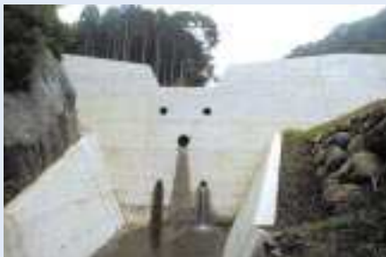
うらかみがわ 浦上川砂防えん堤 (賀茂郡西伊豆町安里地先)
