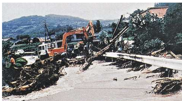
流出土砂により埋もれた県道
