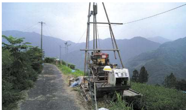
ボーリング調査 (5箇所)
