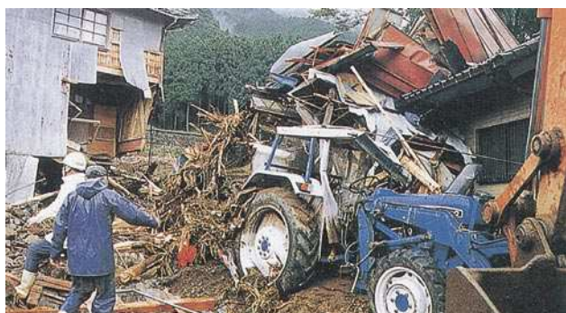
土石流により被災した家屋
