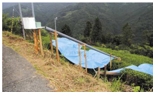
伸縮計 (地すべり頭部)
