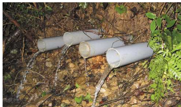
水抜きボーリング工 (応急工事)
