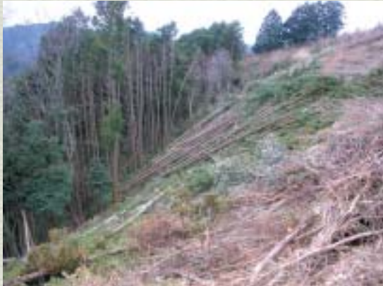
地すべり頭部伐採状況
