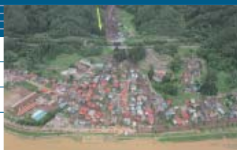
中央自動車道下流部での土石流の流下・堆積状況 (小田井沢川；国際航業(株)・(株)パスコ撮影)
