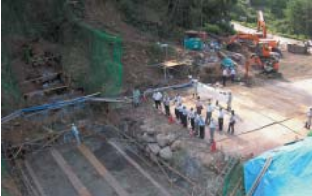
春井手川1号床固工の施工現場
