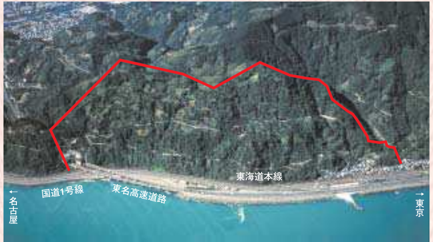
由比地すべり全景（富士砂防事務所提供）
