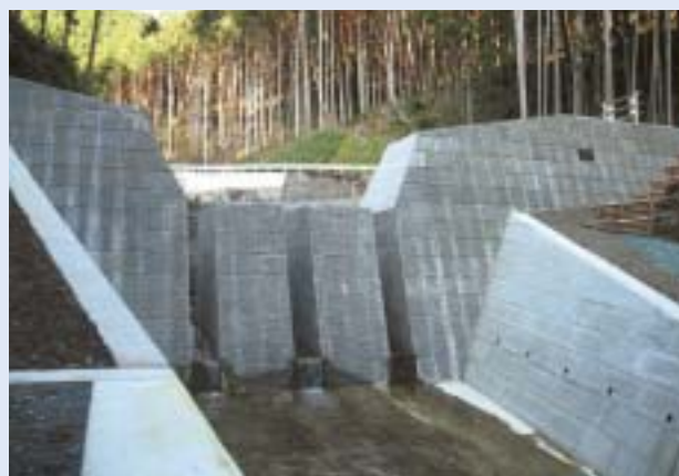
ふじせがわ ●藤瀬川砂防えん堤 (浜松市天竜区石神)
