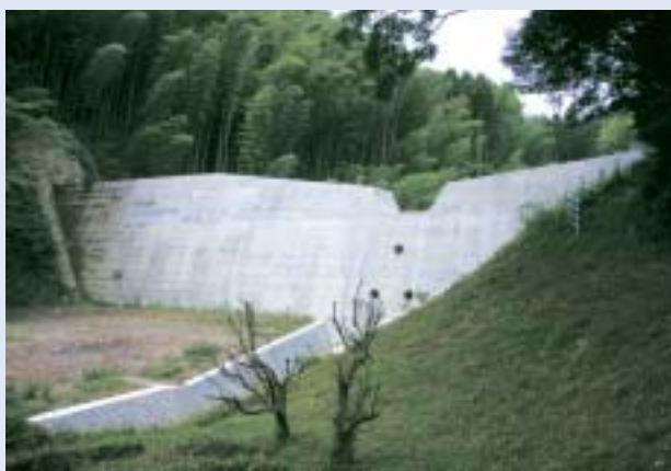
やとざわ ●谷戸沢砂防えん堤 (賀茂郡南伊豆町石井)
