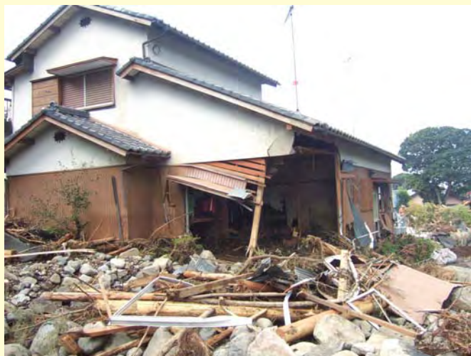
土石流により被災した人家（「大場川」：裾野市茶畑）
