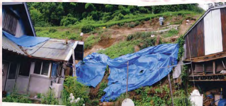
地すべり末端の土砂崩壊
