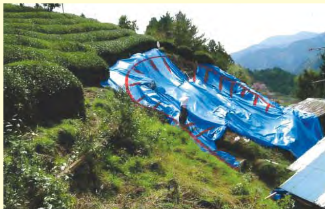
地すべりによる家屋への土砂の押し出し（「峰」：川根町峰）
