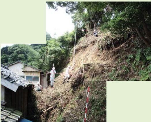
がけ崩れによる人家への被害（牧之原市「勝俣橋向」地区）
