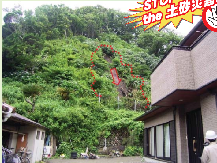
がけ崩れから人家を守った急傾斜施設（賀茂郡松崎町「石部上の山」地区）
