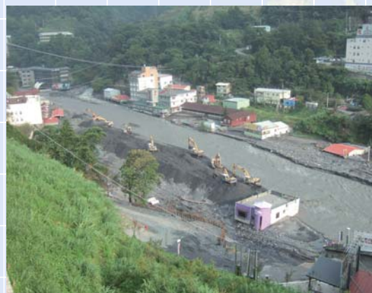
廬山の土砂災害現場状況(台中県)
