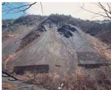
S61山腹工全景
