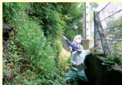
急傾斜地パトロール
