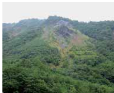
H14山腹工全景
