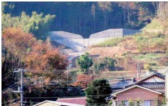
本洞沢砂防えん堤 (伊豆市月ヶ瀬)
