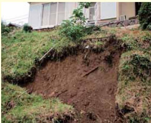
がけ崩れによる人家への被害（沼津市河内御崎）
