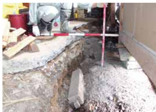
地すべり頭部に発生した段差を伴う亀裂
