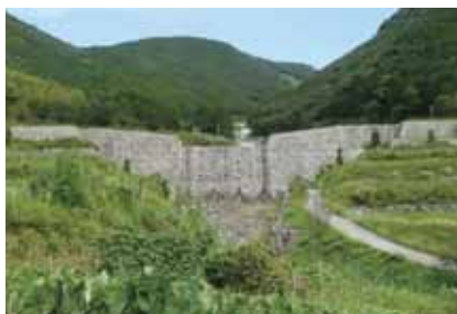
設置された砂防堰堤（遠くに見えるのが崩壊地）
