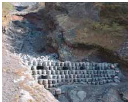
源頭域調査工事現場
