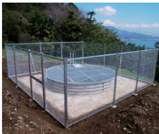
集水井工設置の一例
