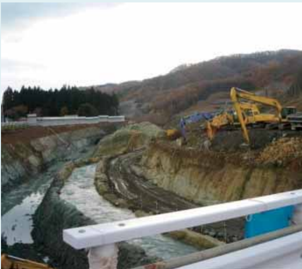
市野々原天然ダムの河道掘削の状況
