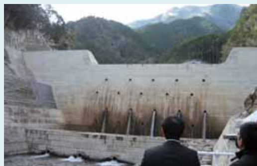
春日谷1号砂防ダム
