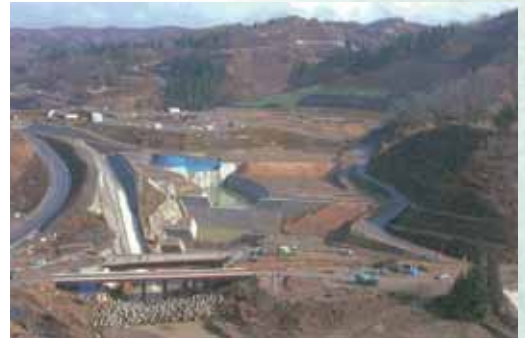
完成した東竹沢砂防えん堤群
