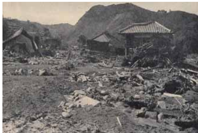
昭和33年9月 狩野川台風の被災状況（旧修善寺町熊坂地区）
