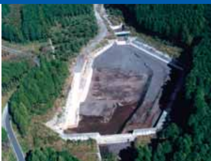
完成直後に土石流を捕捉した風祭沈砂地(除石中の状況)
