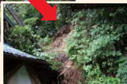
がけ崩れにより人家半壊 (磐田市下野部)
