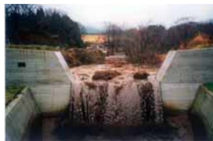
完成直後に土石流を捕捉した栗ノ木第4堰堤(H4.12)
