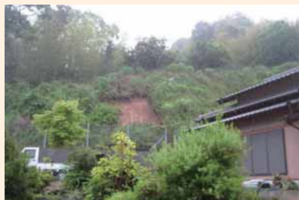
がけ崩れから人家を守った急傾斜施設(御前崎市上朝比奈)
