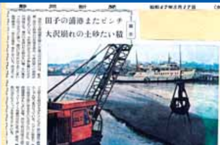
昭和47年 田子の浦港に土砂堆積
