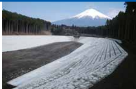
大久保沢沈砂土工
