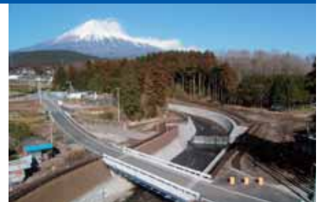
溜野沢溪流保全工
