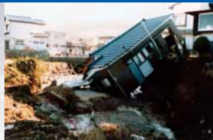
昭和54年 弓沢川流域被災状況
