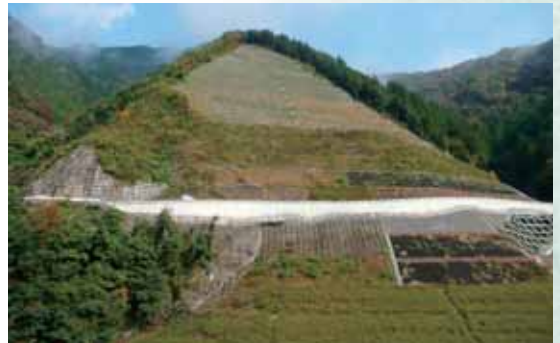
東横山災害関連緊急地すべり対策事業
