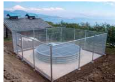
集水井天蓋部
