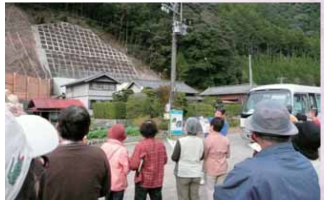
横山急傾斜施設の説明の様子
