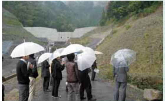
大津谷災害関連緊急砂防事業現場
