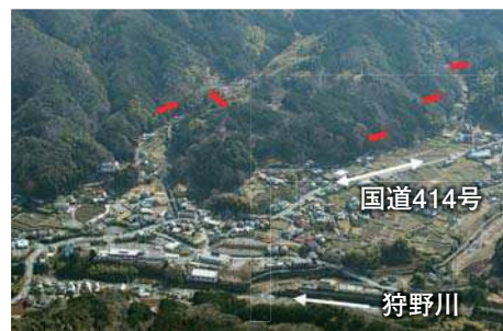
災害時要援護者施設や国道414号を保全する市山地区砂防堰堤群（事業中）
