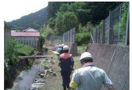
急傾斜地パトロールの実施状況
