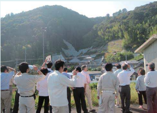
「渡ヶ島寺沢(砂防)」「渡ヶ島久保(急傾斜)」を視察
