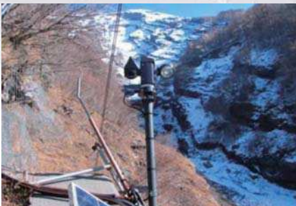
溪流監視用CCTVカメラ
