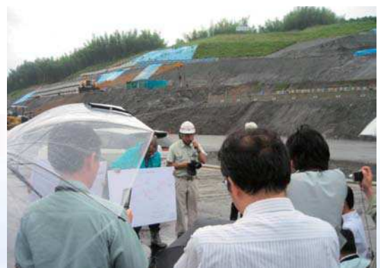
(写真⑤) 新東名高速道路・建設現場
