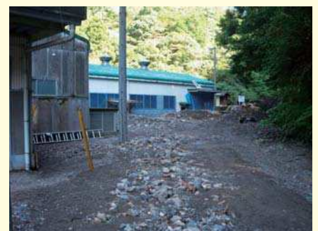
土砂流出による工場の被災 (静岡市葵区横山)
