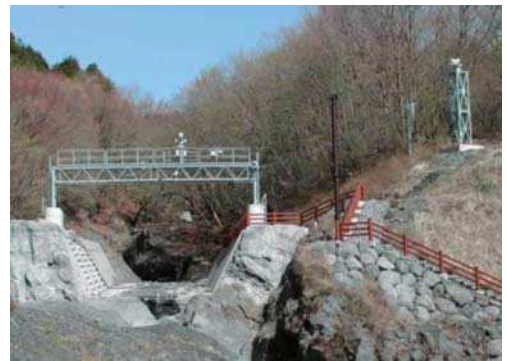
大沢川岩樋部の観測施設
