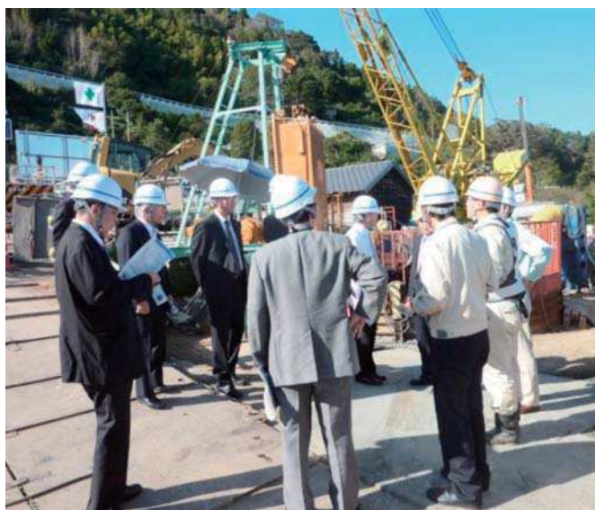
工事現場視察の様子
