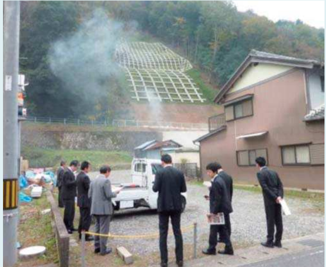
盛住地区急傾斜現場
