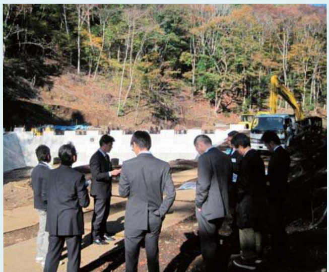
奥の沢川災害関連緊急砂防事業の現場見学
