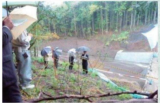
静岡県砂防課からの説明の様子
