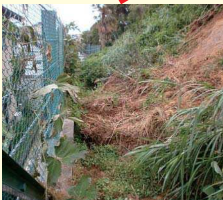
がけ崩れから人家を守った 急傾斜施設 (浜松市西区入野町)
