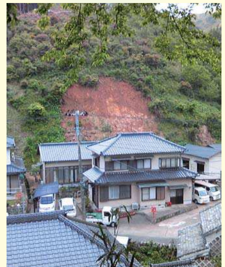
人家裏のがけ崩れ (南伊豆町青市)
