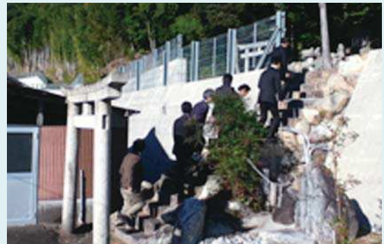
西野地区急傾斜地崩壊対策事業（三重県松阪市西野町）
