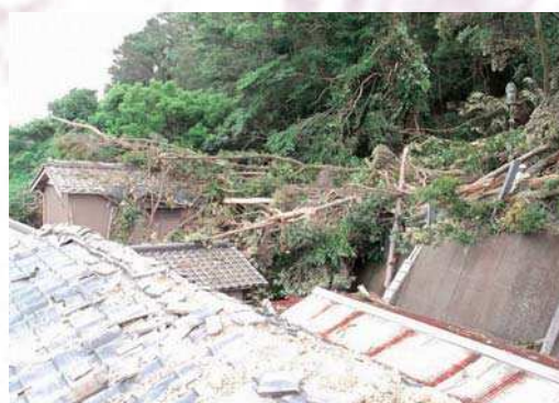
倒木により人家が破損
