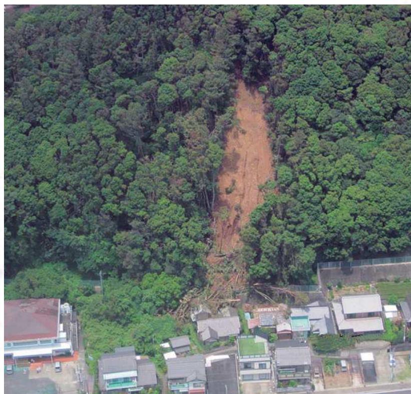
牧之原市静波で発生したがいけ崩れ
