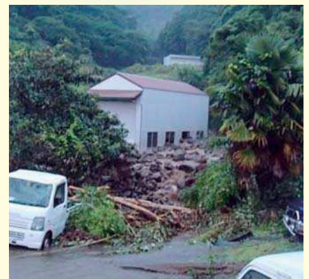
仏沢川土石流被災状況 (西伊豆町田子)
