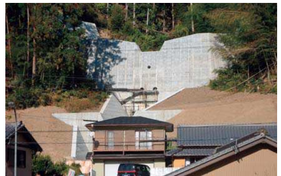
下田沢砂防堰堤(施工中)
