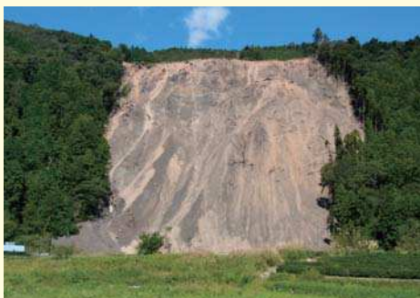
門島地すべり被災状況(浜松市天竜区春野町杉)
