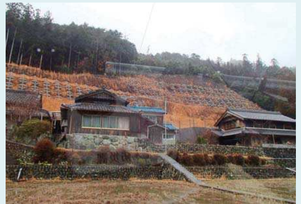
領内地区(地すべり対策)の状況
