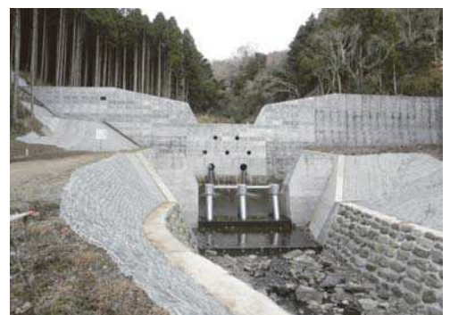
濁川砂防堰堤
