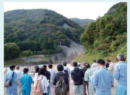
小谷川遊砂池の概要説明を受ける参加者(三重県いなべ市)
