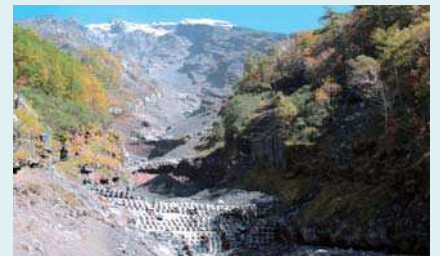
崩壊地と対策工
