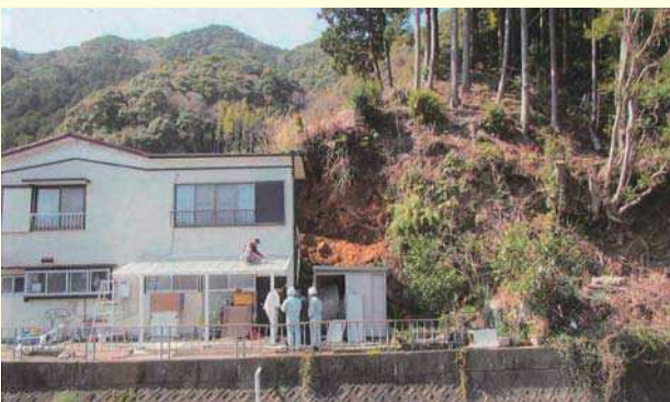
人家裏のがけ崩れ状況(下田市立野)
