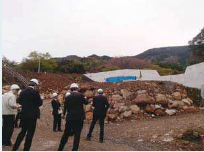
仏沢川砂防事業の現場見学
