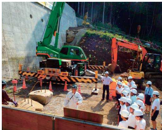
夏加沢工事現場見学の様子(熱海土木事務所：熱海市)
