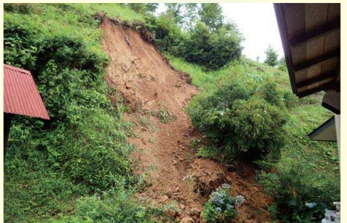
人家裏のがけ崩れ状況(伊豆市大平柿木)
