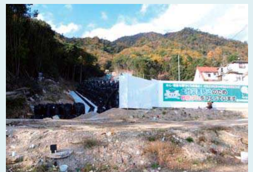
土石流被災地の復旧工事現場(広島市安佐南区)
