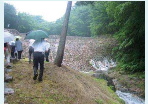
現場研修会の様子(井風呂谷川砂防堰堤)
