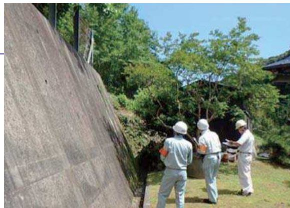
急傾斜地パトロールの状況
