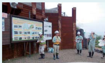
深礎杭工事の説明
