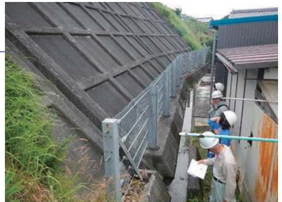
急傾斜地パトロールの状況
