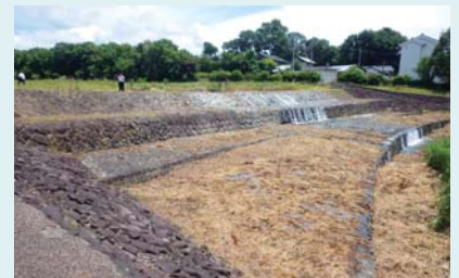
大谷川砂防堰堤
