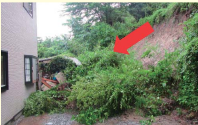
がけ崩れ(浜松市天竜区西藤平)
