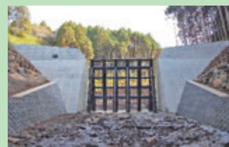
透過型砂防堰堤の新設
