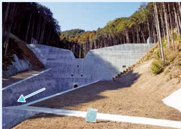
かわさかざわ ●川坂沢砂防堰堤工（富士市岩淵地先）
