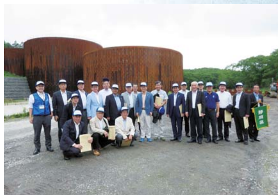
樽前山の直轄火山砂防事業「熊の沢川2号砂防堰堤」
