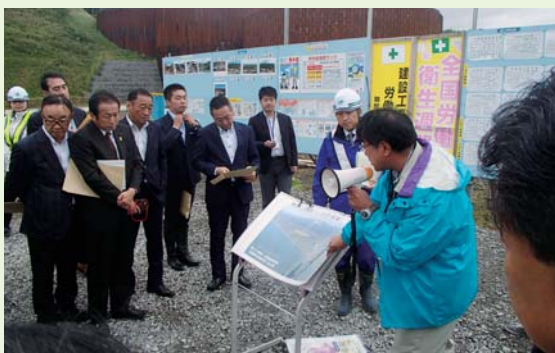
「樽前山直轄火山砂防事業」工事現場にて
