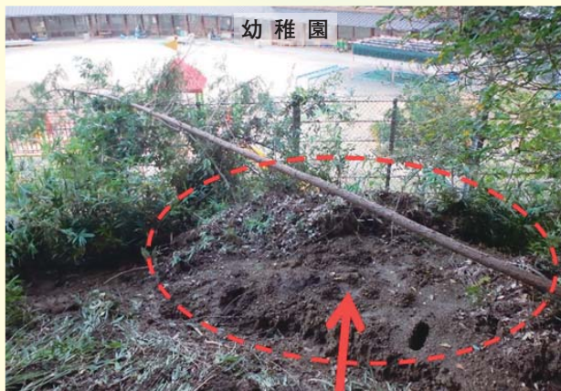
がけ崩れ(掛川市伊達方) 崩壊土砂をくい止め、幼稚園の被害を防いだ
