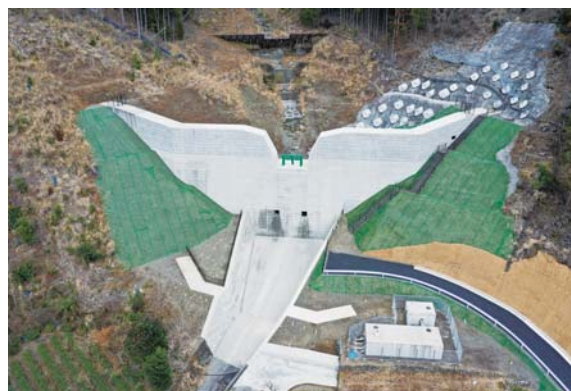
杉の木沢砂防堰堤(H31完成)
