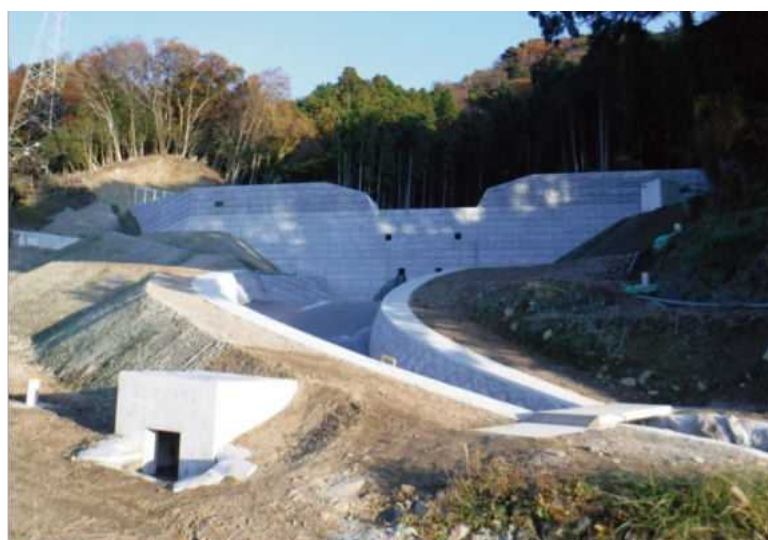
畑洞砂防堰堤(伊豆市)
