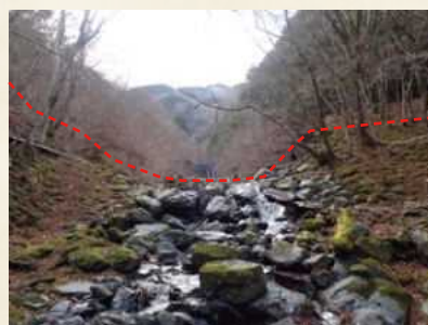
石積堰堤（明治44年施工）
