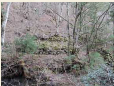
山腹工（石積）（明治35年施工）
