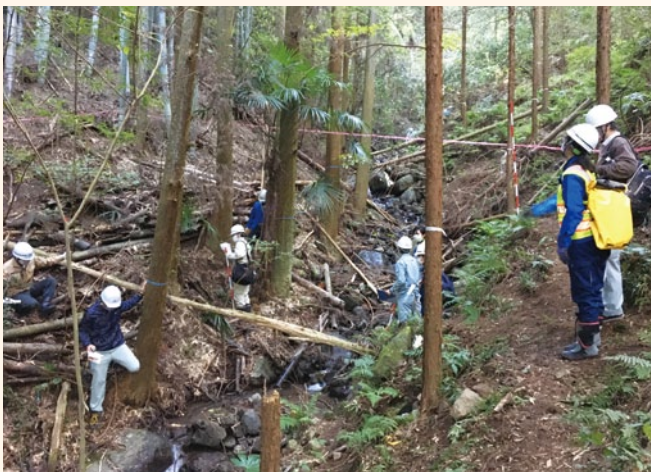
現地調査の状況(静岡市清水区)
