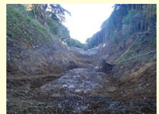
12月23日 既設砂防堰堤の堆積土砂の撤去完了 (写真は12月15日現在)
