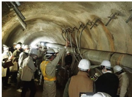
排水トンネルの視察状況
