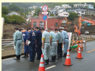
8月3日 現場にて黙とう、復旧に向け工事に着手
