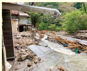
油山川での土石流の被害状況
