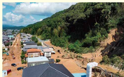
平松藪下Bでのがけ崩れの被害状況
