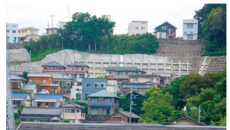
急傾斜地崩壊対策工事(徳倉3丁目谷戸B)
