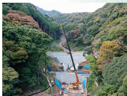
砂防堰堤の施工状況
