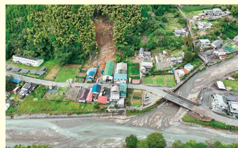
河内中村でのがけ崩れの被害状況
