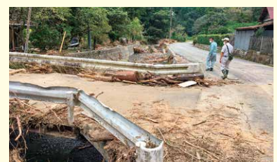
現地調査の状況
