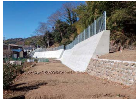
「小浜アハラ」急傾斜地崩壊防止施設
