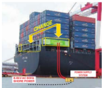
停泊中船舶への 陸上電力供給
