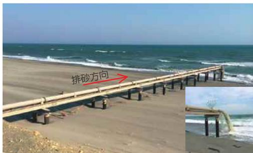
径300mm排砂管と吐出し状況(右下)
