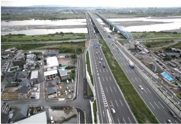
図 新天竜川橋(道路拡幅の例)
