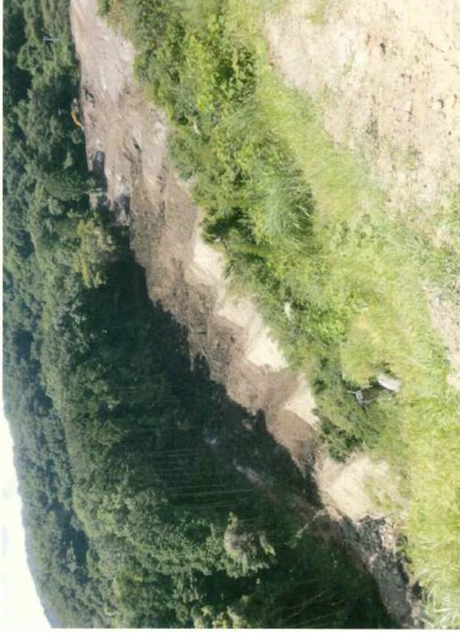
盛土はすでに8～9段行われている。盛土の下部の土留は、2007年5月22日撮影のものと同基本構造（転石土留＋土留柵）は同じである。
