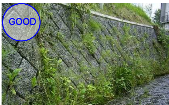
凹凸感のある表面仕上げは、見た目の明度を下げている
