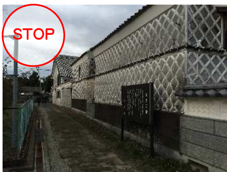
案内板がなまこ壁を隠している
