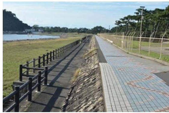
堤防天端の舗装面の過度な装飾が、美しい海岸線の印象を弱めてしまっている望ましくない事例
