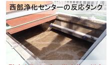
酸素を取り入れ、微生物の働きにより汚水を処理しています。
