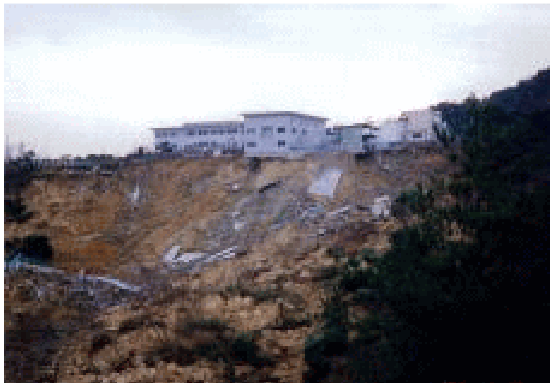
谷埋め盛土が崩落した例 （1995 年兵庫県南部地震時の西宮市内）
