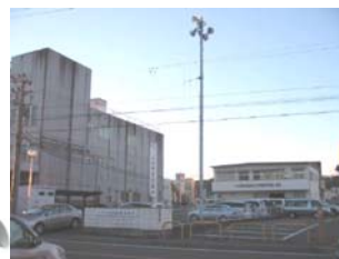
屋外スピーカー(5,829基)
