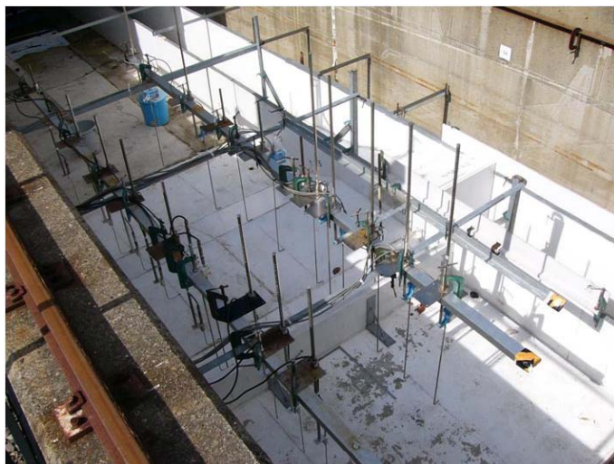
下流上部から撮影
